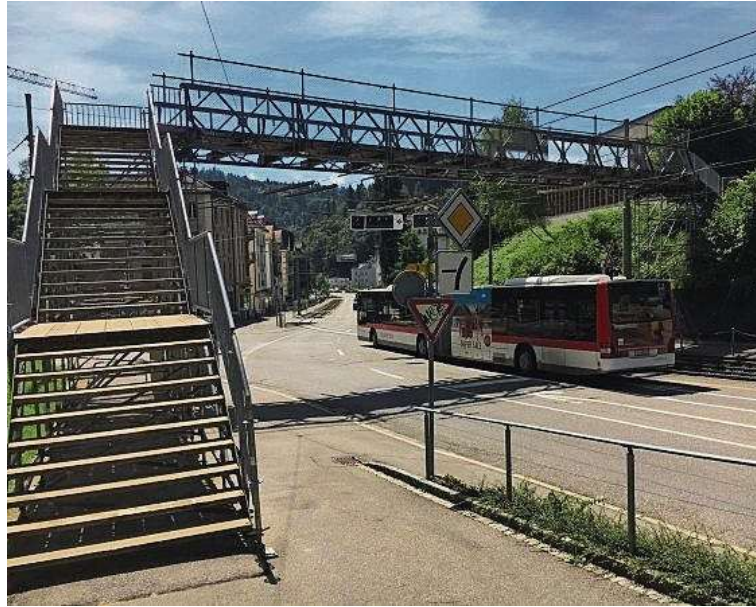
Passerelle, Teufenerstraße, St. Gallen-Riethüsli.
