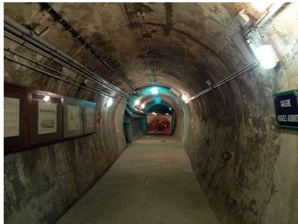
Galerie Hugues Aubriot, Paris (Kanalisationssystem der Stadt Paris)
