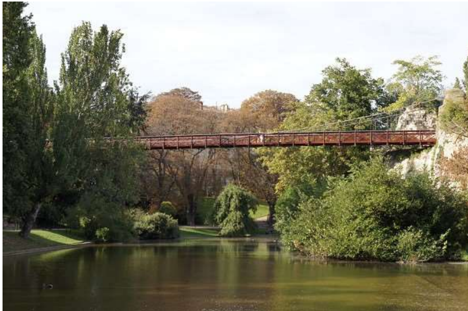
Passerelle dans le Parc des Buttes-Chaumont, Paris
