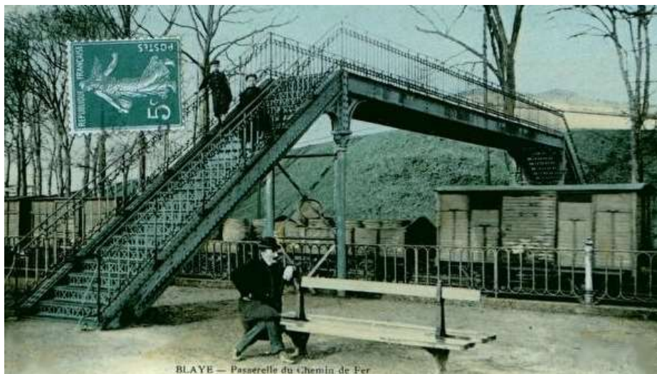
Passerelle du Chemin de Fer, Blaye.
